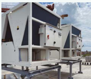
CÉDRUS LIGET, en avancerad anläggning med bl.a. lägenheter, takvåningar och utställningslokaler. Ungern. ECOi-W - ECOi - PACi
